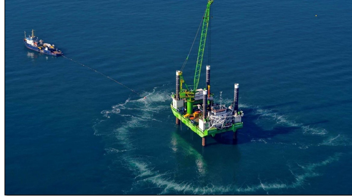
Figuur 9.1: Heien van palen in zee met een 'bellenscherm' wat de verspreiding van onderwatergeluid vermindert OSPAR .
