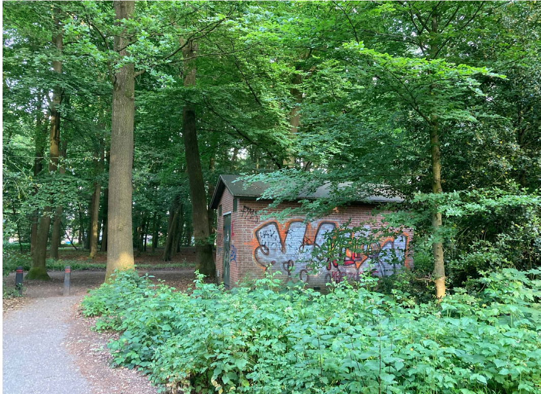
Foto: Apeldoorn - Trafohuisje met graffiti
