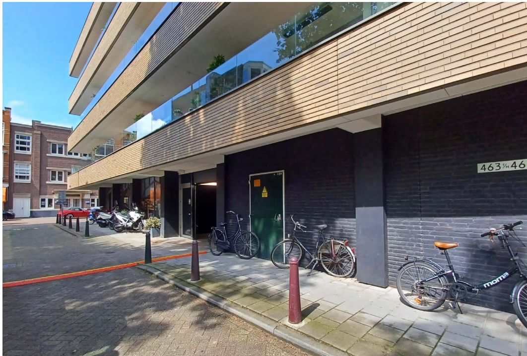
Foto: Den Haag - Trafohuisje inpandig in appartementencomplex
