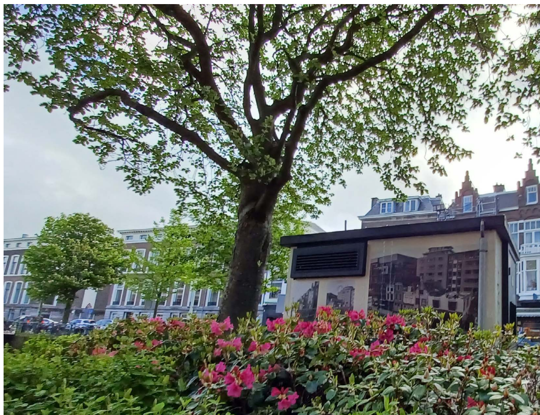
Foto: Den Haag - Trafohuisje met informatiebord
