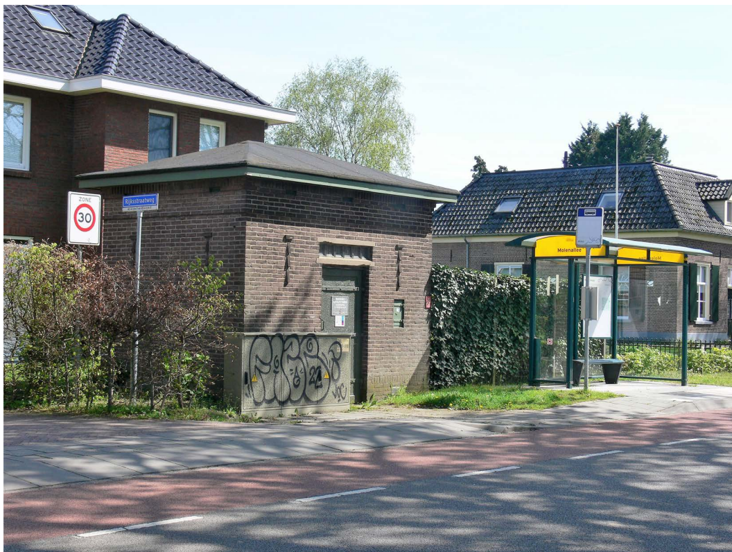
Foto: Wilp - Trafohuisje langs een doorgaande weg
