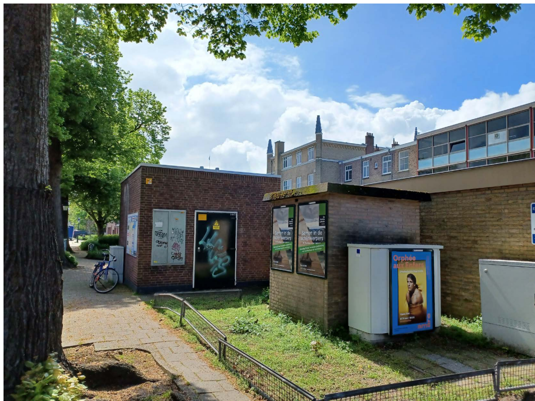
Foto: Den Haag - Verschillende installaties in de buurt van het VNG-kantoor
