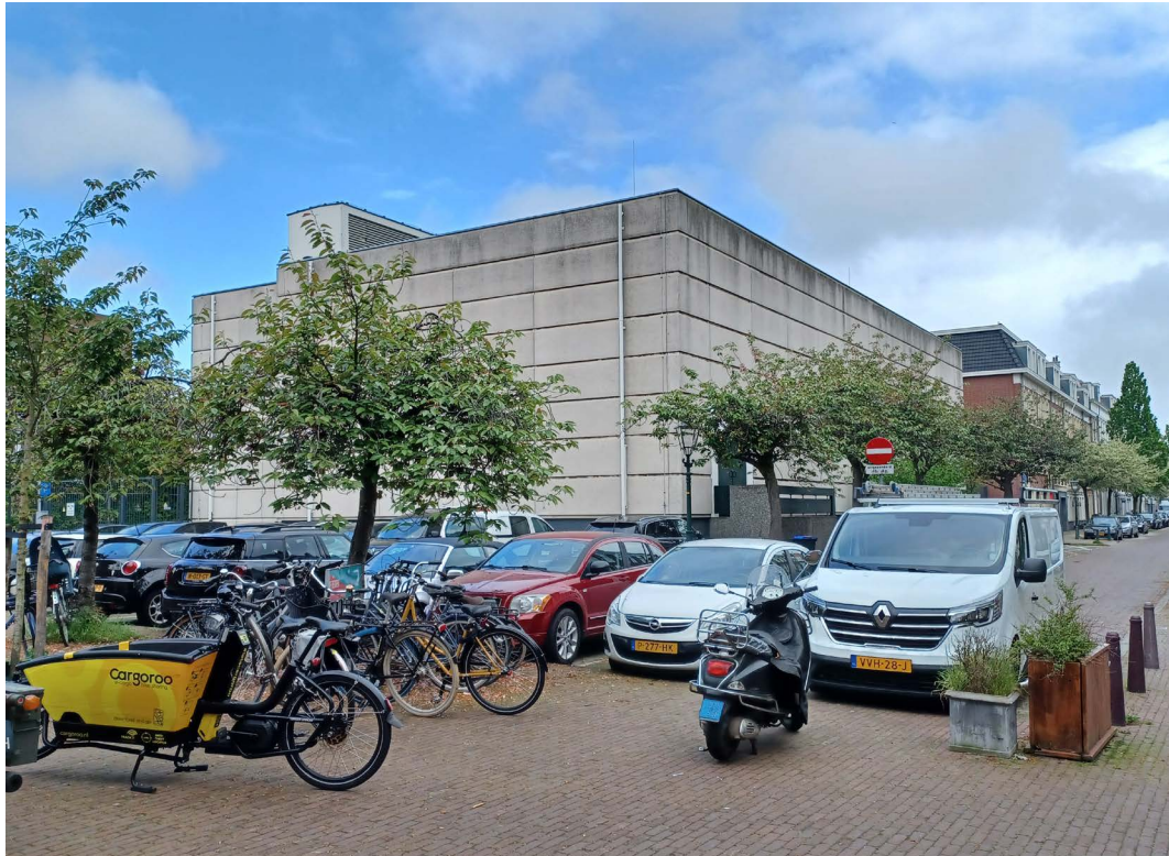
Foto: Den Haag - Onderstation in woonwijk
