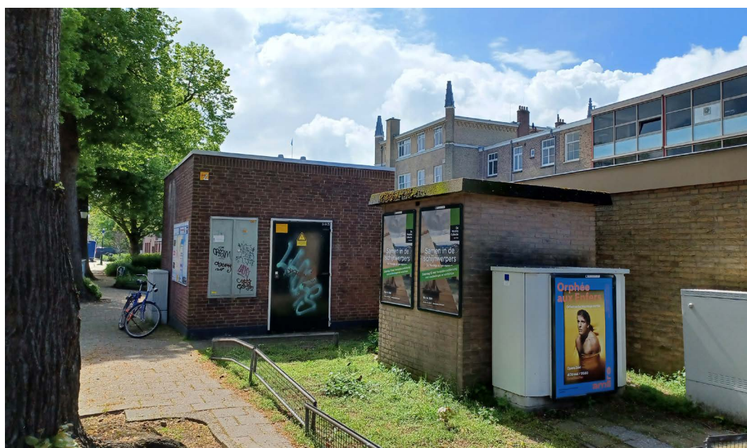
Foto: Den Haag - Verschillende installaties in de buurt van het VNG-kantoor.
