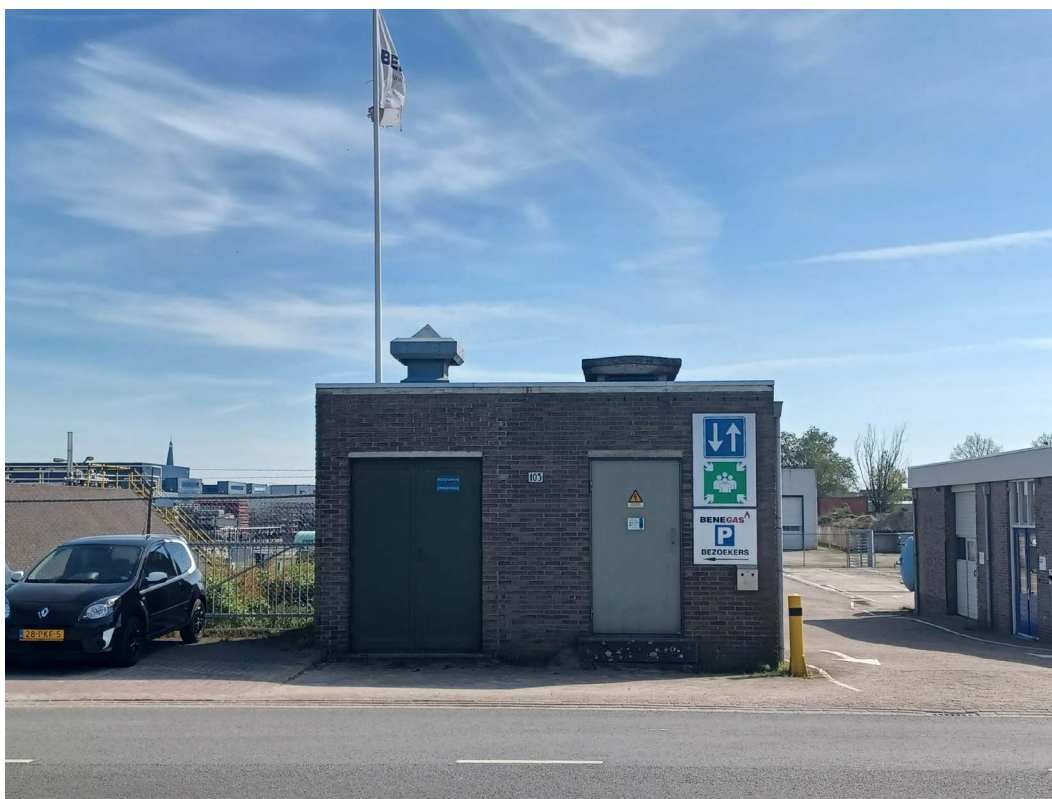
Foto: Zutphen - Trafohuisje op industrieterrein
